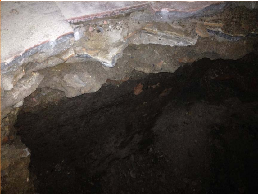
Foto 8. Vista de la banda sud, paret sud del soterrani (UE 6).
