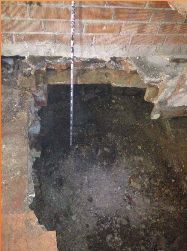
Foto 5. Vista exterior de la volta del soterrani (UE 5).
