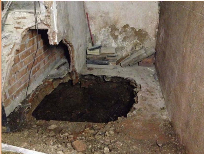
Foto 10. Estat final de l'indret un cop finalitzats els treballs d'obertura.
