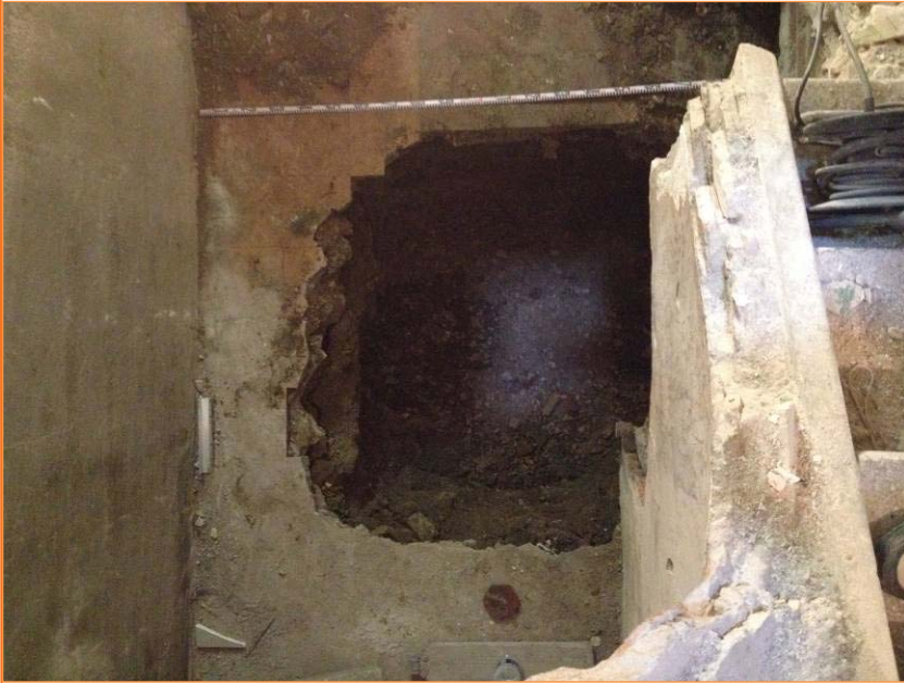
Foto 7. Vista general després dels treballs d'obertura del fossat d'ascensor.
