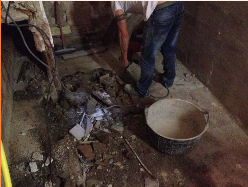
Foto 2. Inici dels treballs d'obertura del forat d'ascensor (UE 1).
